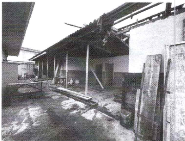
Figura 1 - Calçadas e piso interno da área da churrasqueira dos fundos a serem demolidos
